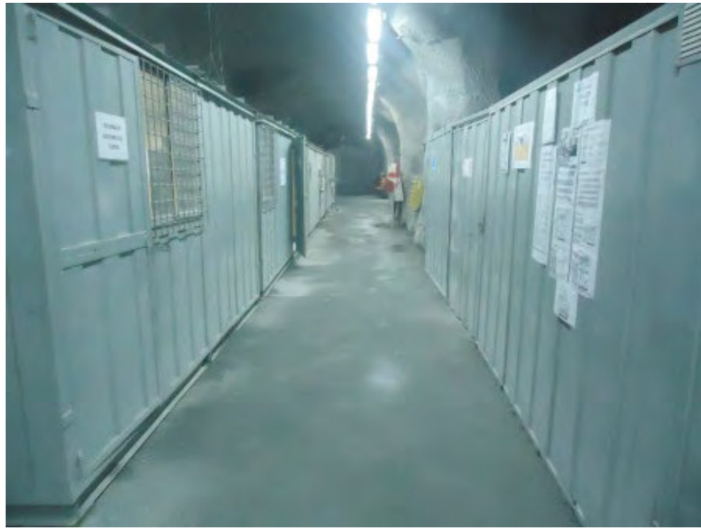
Figura 3.- Ancho vía peatonal, mínimo 1,10 m.
