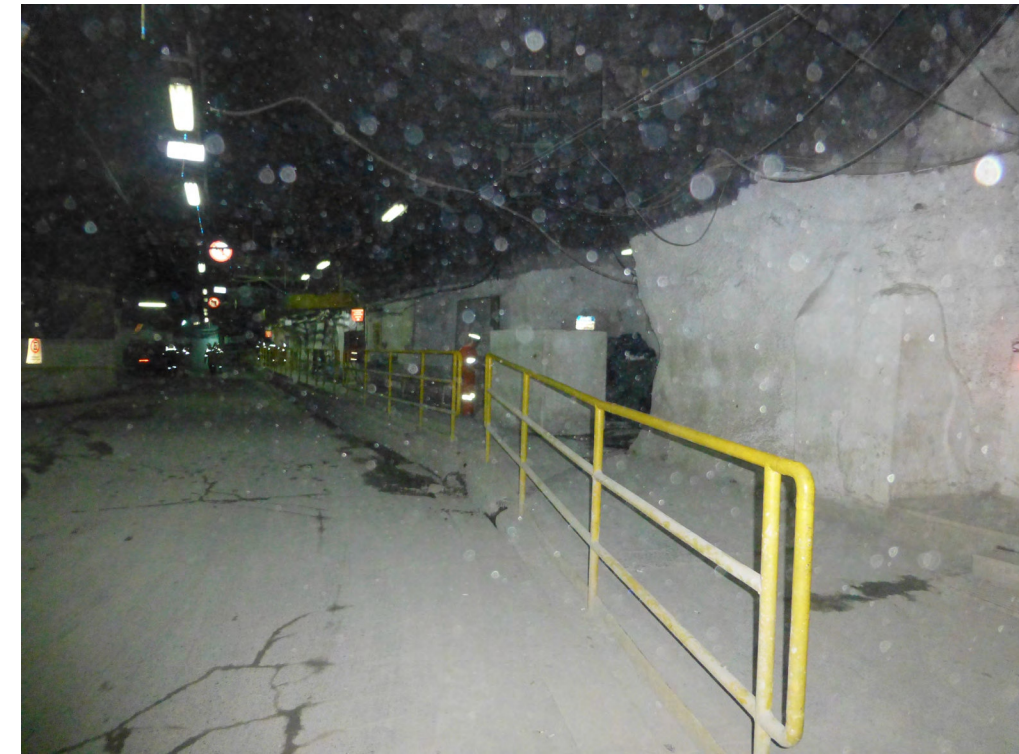
Figura 5.- Barreras que segregan la vía de circulación vehicular de la peatonal.
