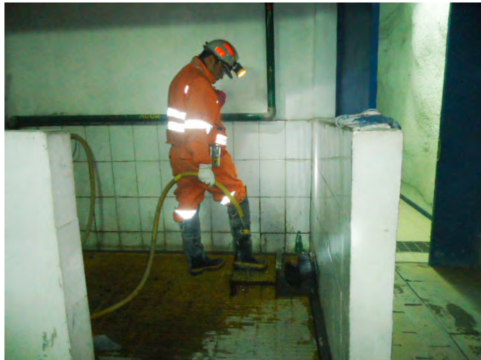
Figura 12.- Ejemplo de instalaciones para el servicio de lavado de botas.
