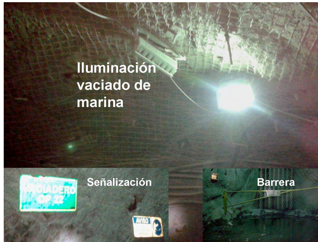
Figura 19.- Ejemplo de iluminación en el punto de descarga de marina.
